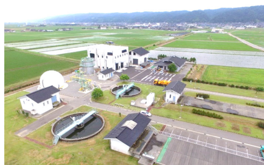
図2 中能登町のバイオマスメタン発酵施設
